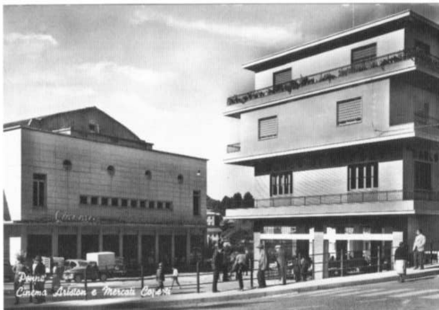
Cinema Ariston al termine della costruzione
